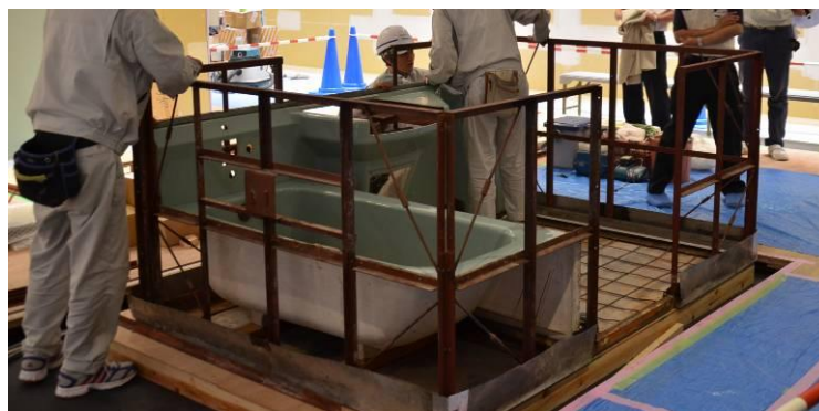
2015年6月、TOTOミュージアムに設置中の初代ユニットバスルーム。FRPの洗面カウンター・浴槽等、大半の部材を1964年当時のまま移設
